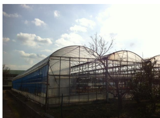
*張替えを待つ3号ハウス 破れたところを補修しながら 使用していました
