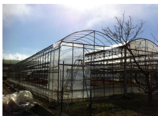
*張替え工事開始 古いビニールがあっという間に 剥がされていきます
