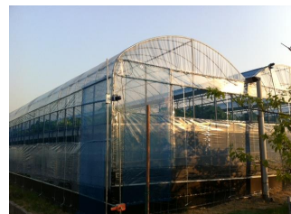
*張替え工事完了 屋根(谷)と側面(上段)を電動に変更 換気(開閉)が少し楽になりました
