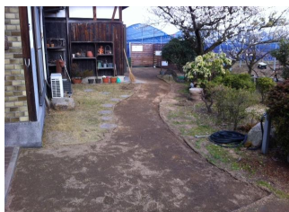
*改修部分を削って整地
