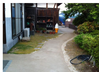
*固まる真砂土で舗装し段差解消
